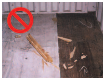
Мусор и подкладочный материал
